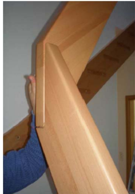
29b. Handlauf verschrauben
