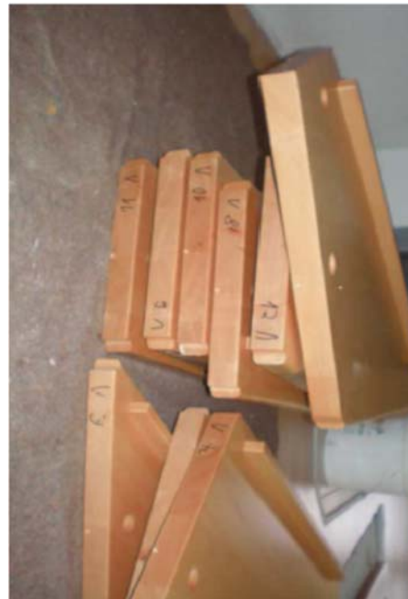
2. Stufen kontrollieren, sortieren
