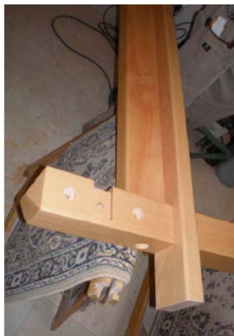
15b. Austrittsstufe-Pfosten montieren
