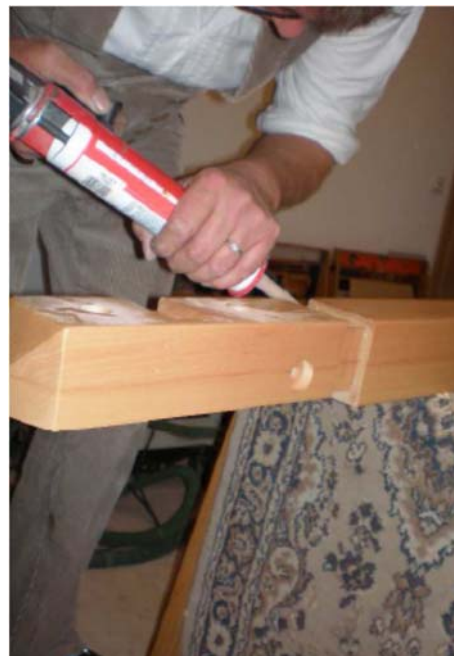
16. Vorletzte Stufe Austrittsposten montieren
