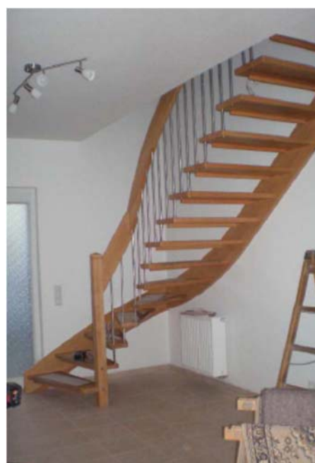
33a. Fertigstellung von unten
