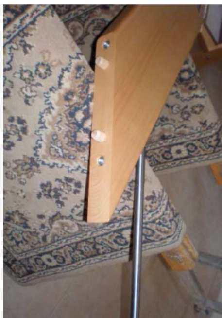
28b. Unterer Handlauf: erster Stab
