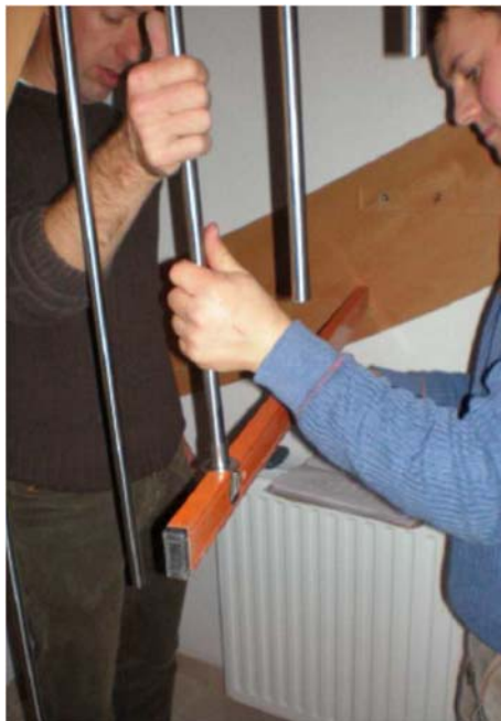
30. Alle Stäbe waagrecht einsetzen
