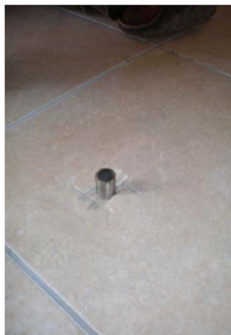
24. Hülse bis auf Rohbeton einsetzen
