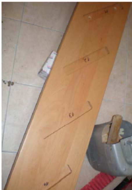
3. Wangen kontrollieren, sortieren
