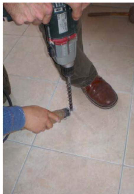
22. Fliese anflexen und bohren
