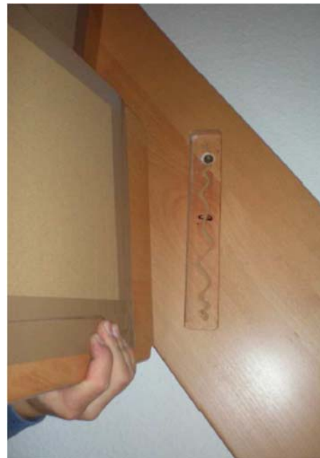
31a. Stufen einsetzen
