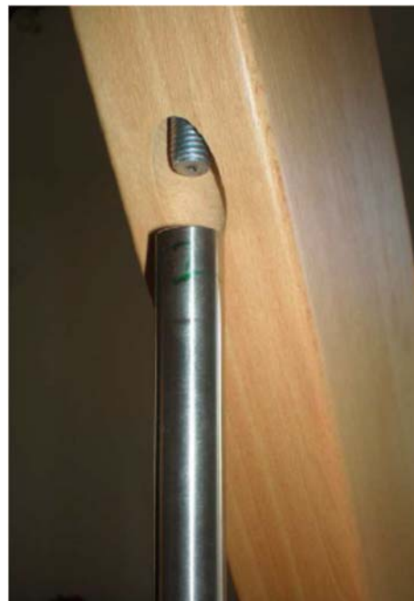
28a. Geländerstäbe nummeriert einsetzen
