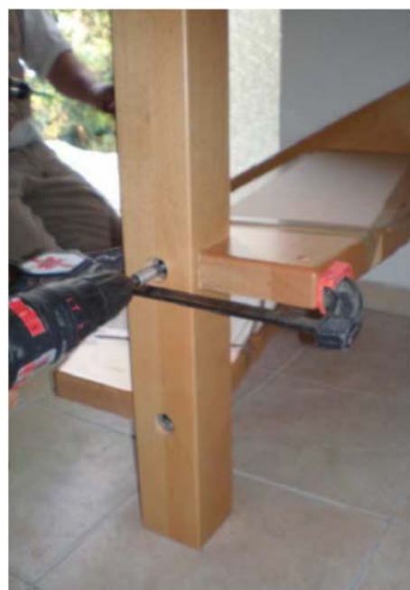
27a. Antrittspfosten einsetzen
