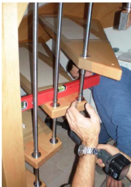
32b. Stufen waagrecht verspannen
