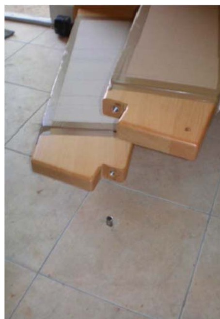
25b. Antrittsstufen vormontieren
