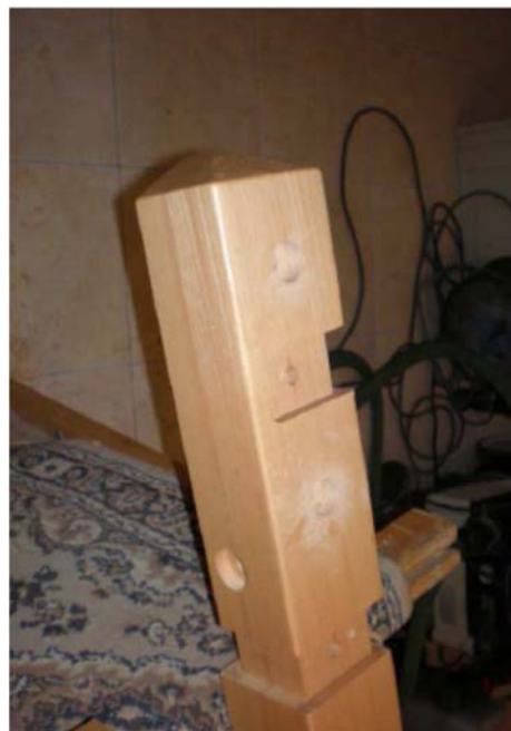
15b. Austrittsstufe-Pfosten montieren
