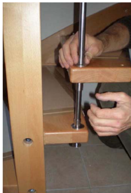
32a. Stufen mit Abstandshülsen verschrauben
