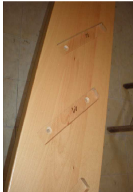
4. Wangen vorbohren (Wandmontage)
