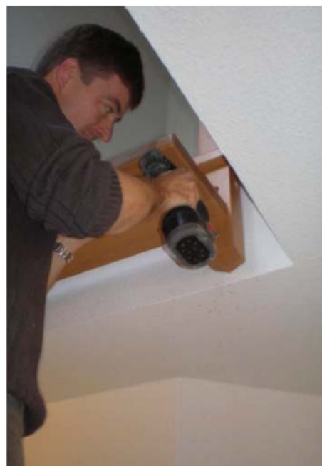
18c. Austrittselement montieren
