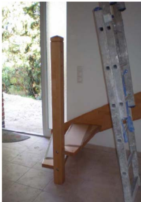
28b. Unterer Handlauf: erster Stab
