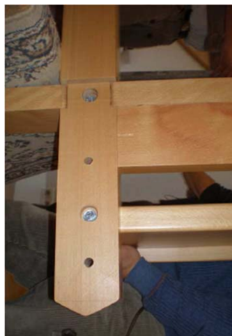
16. Vorletzte Stufe Austrittsposten montieren
