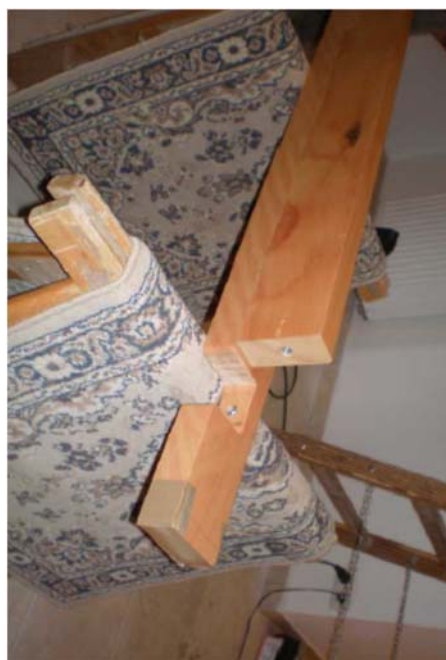
12. Austrittsstufe einmessen, kürzen
